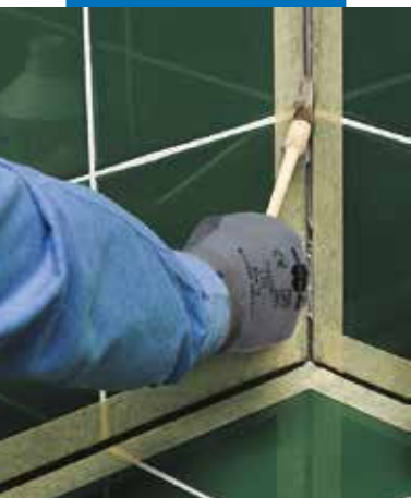
Application of Primer FD
